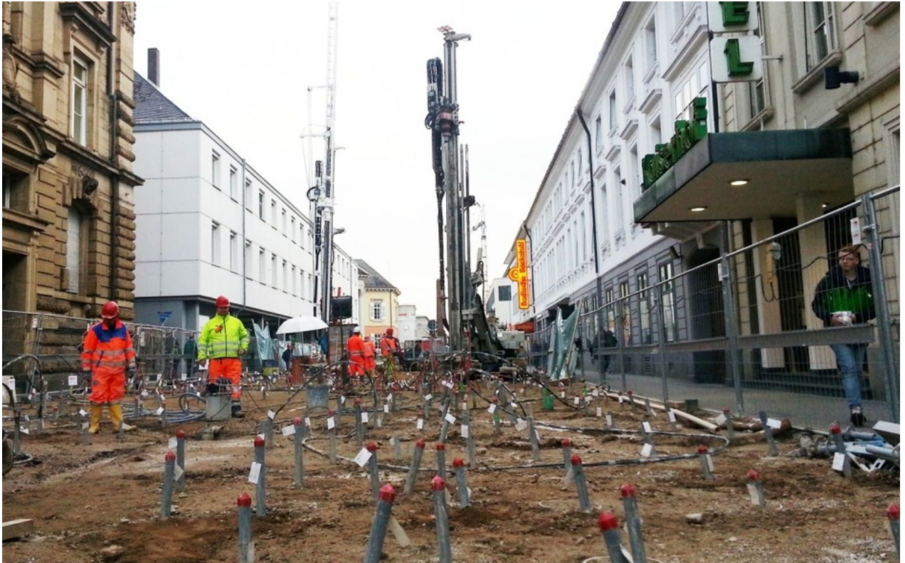
Bohr- und Injektionsarbeiten
