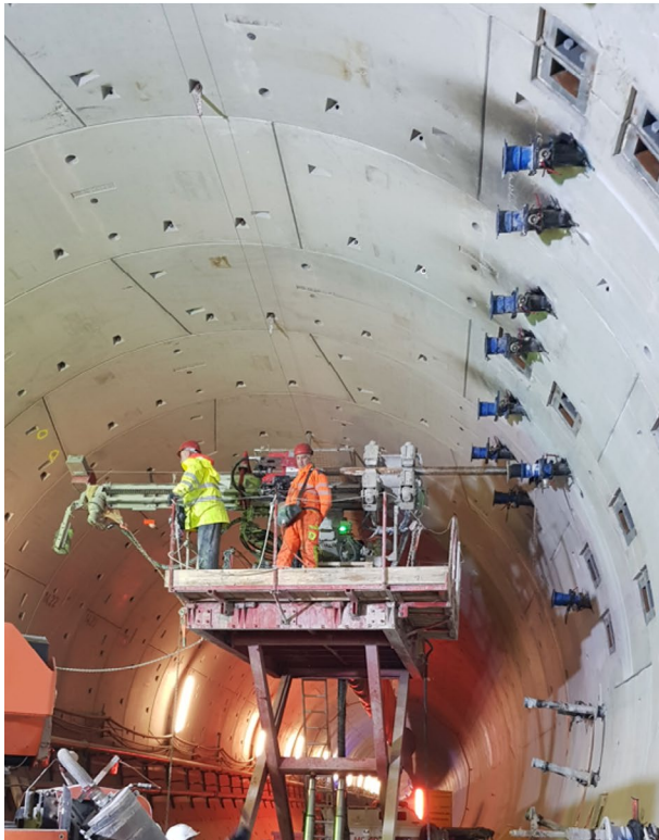
Bohren des oberen Teils - Comacchio MC 4 auf Plattform
