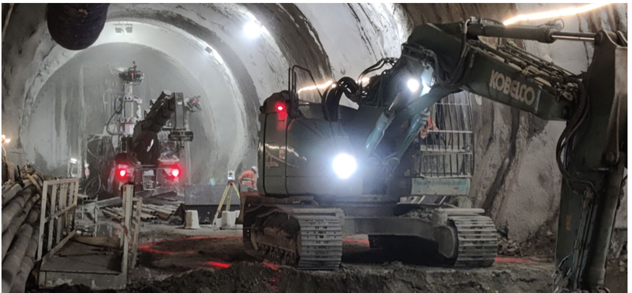
Die Bohrarbeiten laufen parallel zu dem Aushub in der Strosse.
