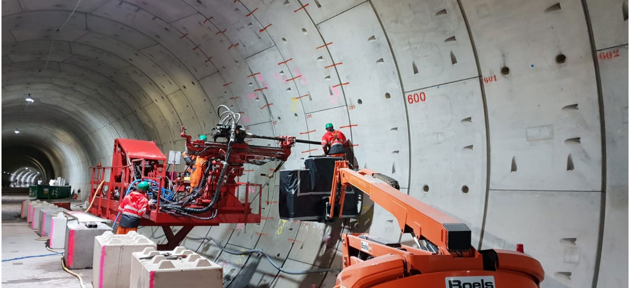
Bohren und Gefrierrohren Installation
