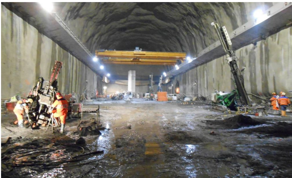
Bohrgeräte in Arbeit in die Kaverne
