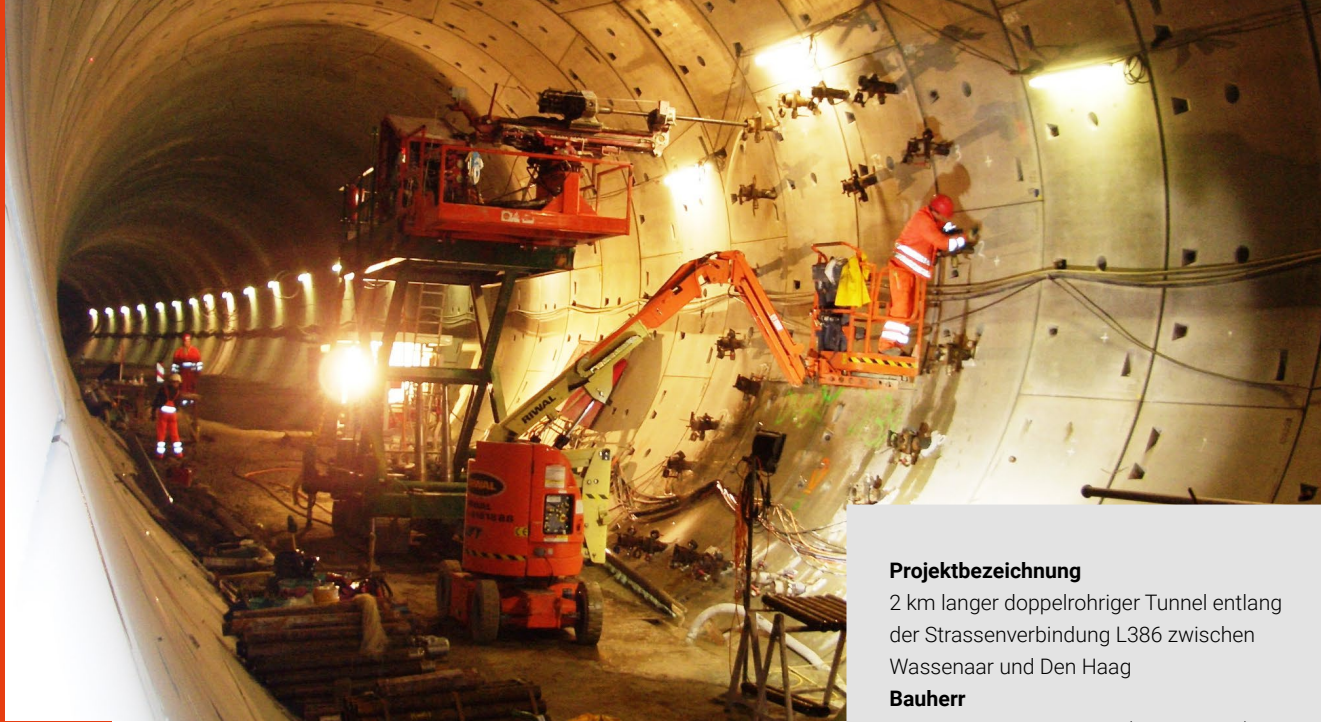
Bohrgerät auf Plattform vor dem Querschlag
