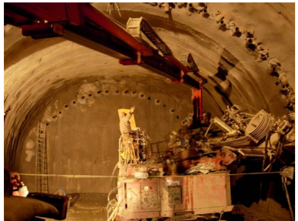
Bohrgerät RODIO SR510 im Tunnel Langgalerie Los 1300
