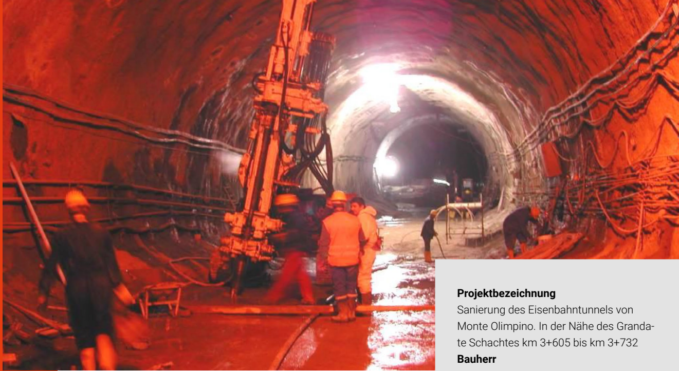
RODIO Bohrgerät Casagrande C8 während der Bohrarbeiten
