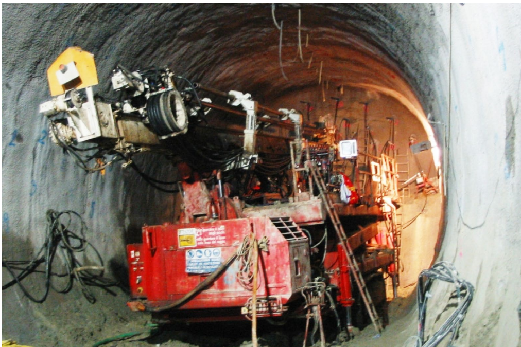
Bohrgerät RODIO SR 510 in Tunnel unter Druckluft
