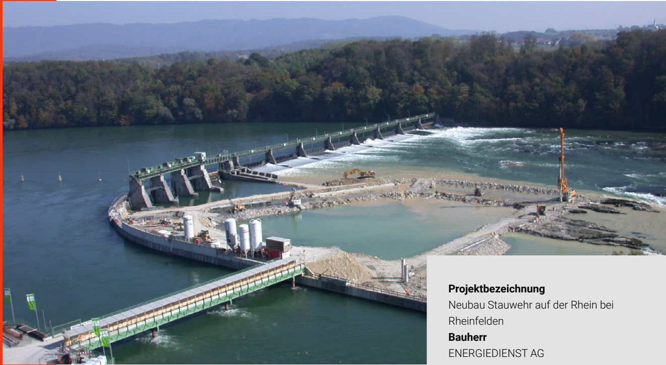
Draufsicht Stauwehr Rheinfelden
