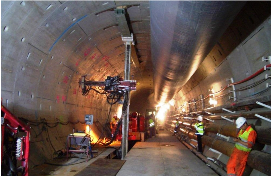
Bohrgerät montiert über die vertikale Lafette
