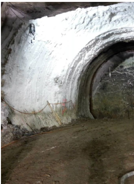
Gefrorener Boden Tunnel NW
