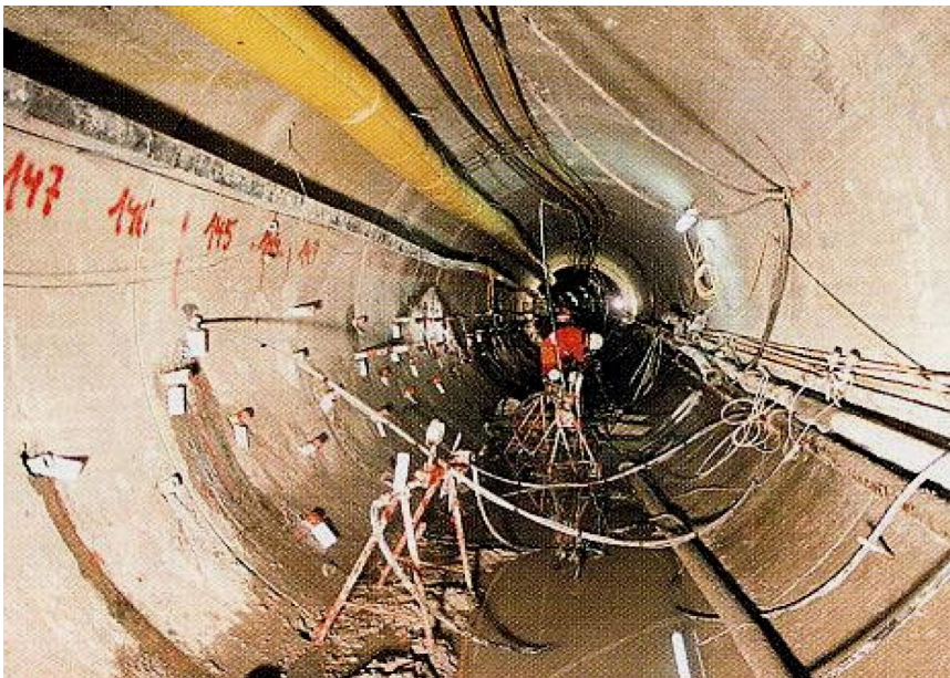
Injektionsarbeiten aus der Stollen
